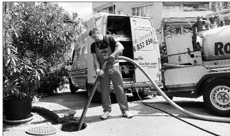
In Notfällen ist «RohrMax» rund um die Uhr erreichbar.
