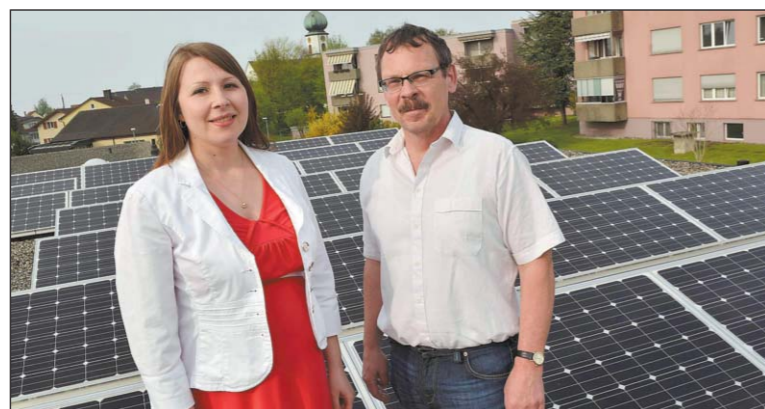
Die designierte Vereinspräsidentin Irina Moor mit Gemeinderat und Förderer der alternativen Energie Roland Etter inmitten einer Steinacher Photovoltaikanlage. Bild: Fritz Heinze
