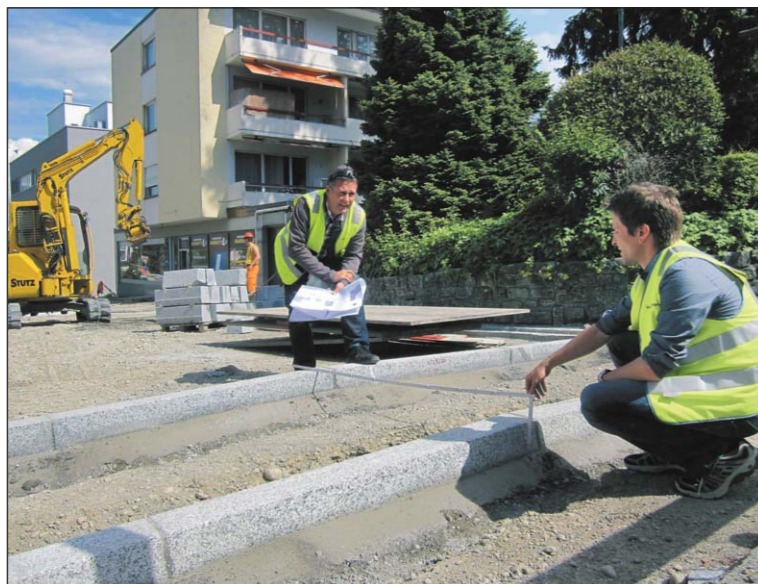
Stadtrat Reto Stäheli (links) und Stefano Sinopoli, Projektleiter Tiefbau, bei einer Baustellenkontrolle.
