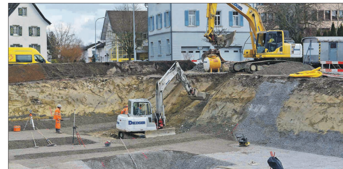
Auf der Liegenschaft an der Ecke Haupt-/Schulstrasse wird am Aushub gearbeitet.
