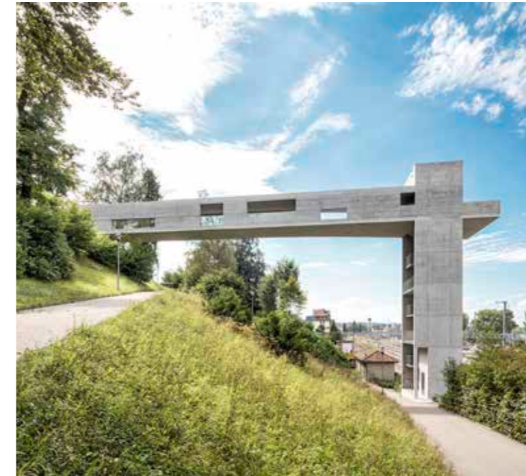
Kompetenz im Konstruktiven Ingenieurbau: Neubau Aufzug Rorschach mit 30 Meter hohem Liftturm und 40 Meter langer Fussgängerpasserelle.
