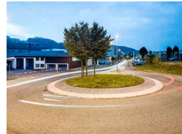
Kompetenz im Tiefbau: Erneuerung Autobahn-Anschluss St.Gallen-Winkeln, Ausbau Bildstrasse und Verlängerung Ein- und Ausfahrtspuren Winkeln bis Sitterviadukt.
