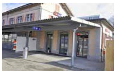
Der neue Billettschalter befindet sich auf der Steinacher-Seite des Bahnhofs.
