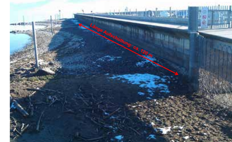
Die Hafenmole wird im abgebildeten Bereich auf einer Länge von zirka 120 Metern mit schwereren Steinen aufgeschüttet.
