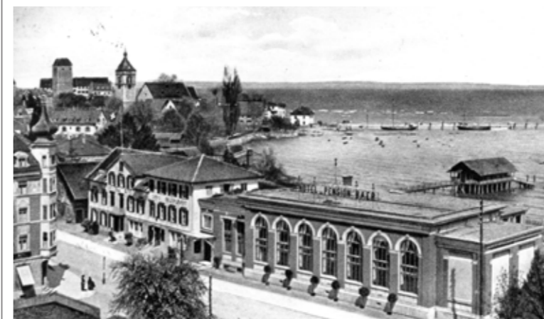
Blick vom Bahnhofplatz aufs Hotel «Baer au lac» (heute Metropol). Hinter dem «Baer» entsteht im Jahr 1922 die Seepromenade: Das bis dahin bestehende Naturufer wird mit Aushubmaterial vom Hafendamm aufgeschüttet, eine Sandsteinmauer gebaut und eine Kastanienallee gepflanzt. Viele Arbeitslose arbeiten mit.
