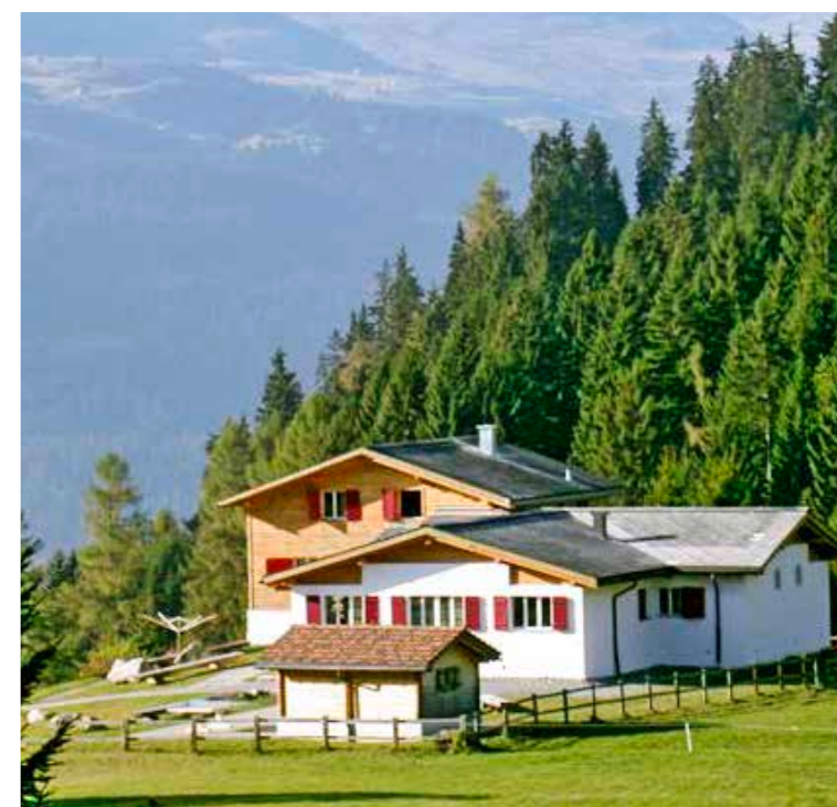
Das Lagerhaus Gonda der Schulgemeinde Goldach in Ladir (GR).
