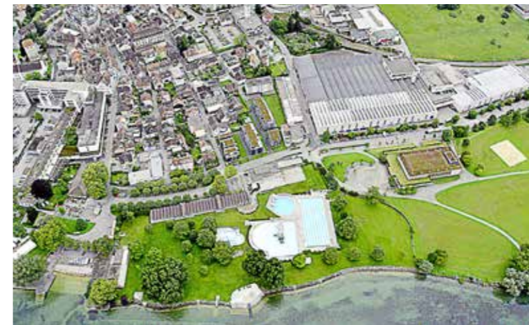
Für die vierte Etappe, die beim neuen Schwimmbad und dem neuen Wäscheplatz endete, wurde ein Kreditbetrag von 460 000 Franken beantragt.
