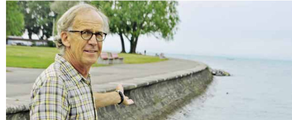
Stadtrat Peter Gubser, verantwortlich für die Freizeitanlagen, zeigt auf die Ufermauer zwischen Fliegerdenkmal und Wäscheplatz: «Die Quaimauer ist jetzt 70 Jahre alt und hat langsam ihre Lebensdauer erreicht.»
