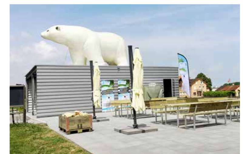
Das Werk von Lernenden der Otto Keller AG: Der neue Velounterstand mit «Klimamacher»-Maskottchen auf dem Dach, vorne der neue Grillplatz.
