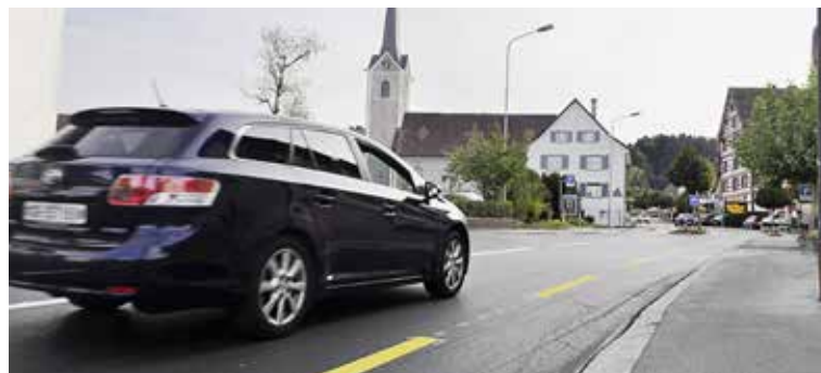
Über den frisch eingebauten Flüsterbelag ins Dorf Roggwil: Der Verkehr rollt seit einer Woche halb so laut.
