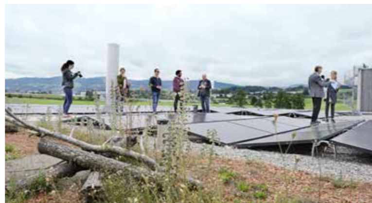
Auf dem Dach der neuen Anlage befindet sich eine 1400 Quadratmeter grosse Photovoltaik-Anlage. Daneben werden unbebaute Flächen naturnah bepflanz. Diese kleinen Biotope findet man überall auf dem Gelände der ARA.
