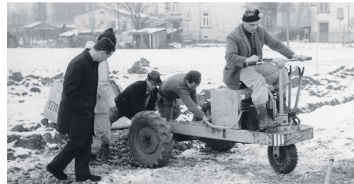
Alois Purschke auf der Baumaschine bei den Erstellungsarbeiten des Fussballplatzes im Schöntal im Jahr 1967. Archiv
