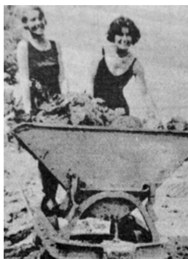
Auch Frauen leisteten Fronarbeit beim grossen Gemeinschaftswerk, dem Bau des Strandbades Arbon. (Archivbild: AZ)
