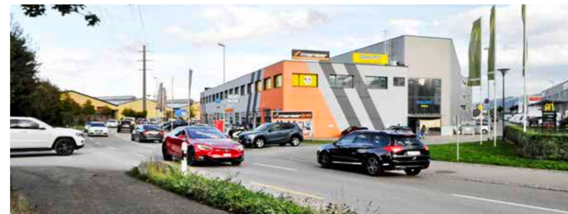
Das starke Verkehrsaufkommen auf der Roggwilerstrasse erschwert die Einfahrt von der Kupferwiesenstrasse (links, weisses Auto) und von der Pündtstrasse (rechts, Seite MC Donalds/Manser).
