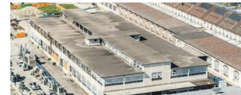
Das Zentralmagazin im WerkZwei stammt aus dem Jahr 1954 und diente unter anderem als Lager. Auch diese Halle wäre laut Thurgauer Regierung architektonisch und kulturhistorisch interessant als Museumsstandort.
