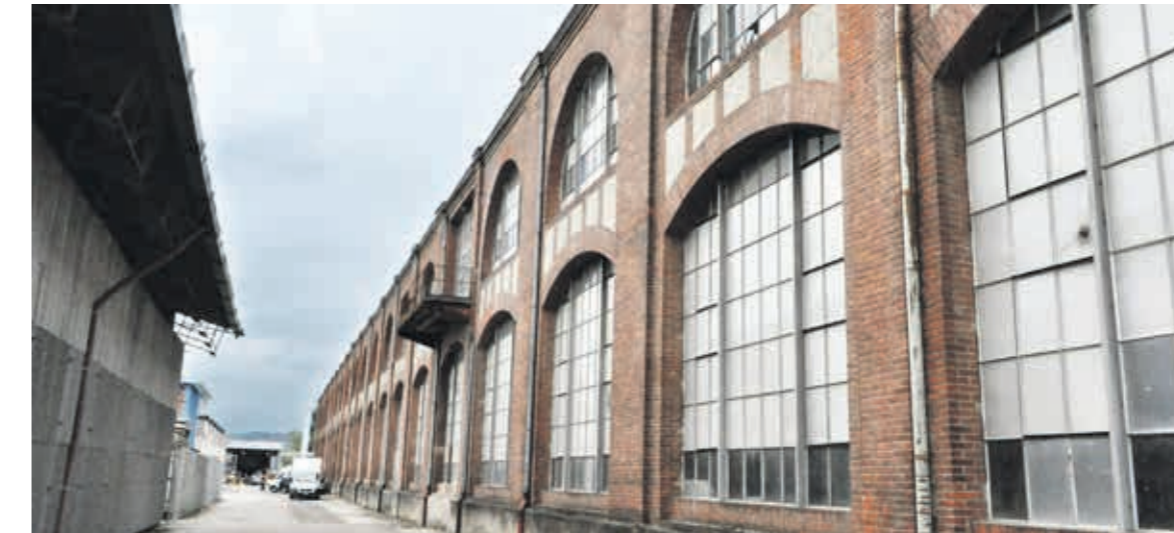
Die ehemalige Webmaschinenhalle im WerkZwei, gebaut in den Jahren 1909 bis 1911. Die Thurgauer Regierung nimmt diese Halle als möglichen künftigen Museumsstandort ins Visier.
