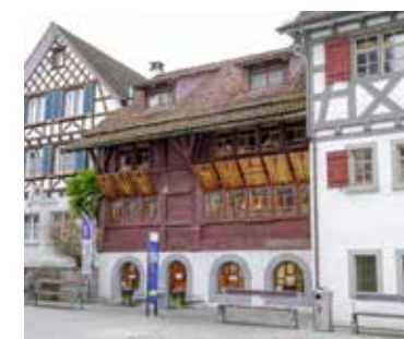
Im Bohlenständerhaus von 1471 an der Schmiedgasse hat es gebrannt. kim
