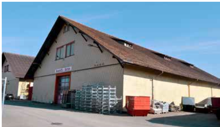
Diese Halle der Firma Allmendinger – sie liegt zwischen dem Horner Westhafen und der Seestrasse – soll zur CBD-Produktionshalle umfunktioniert werden.
