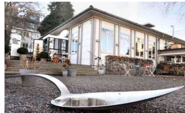
Die «Wunderbar» muss den «Löffel abgeben»: Das 1944 erstellte und von der Firma Saurer lange als Kantine genutzte Gebäude an der Weitegasse 8 darf abgebrochen werden.
