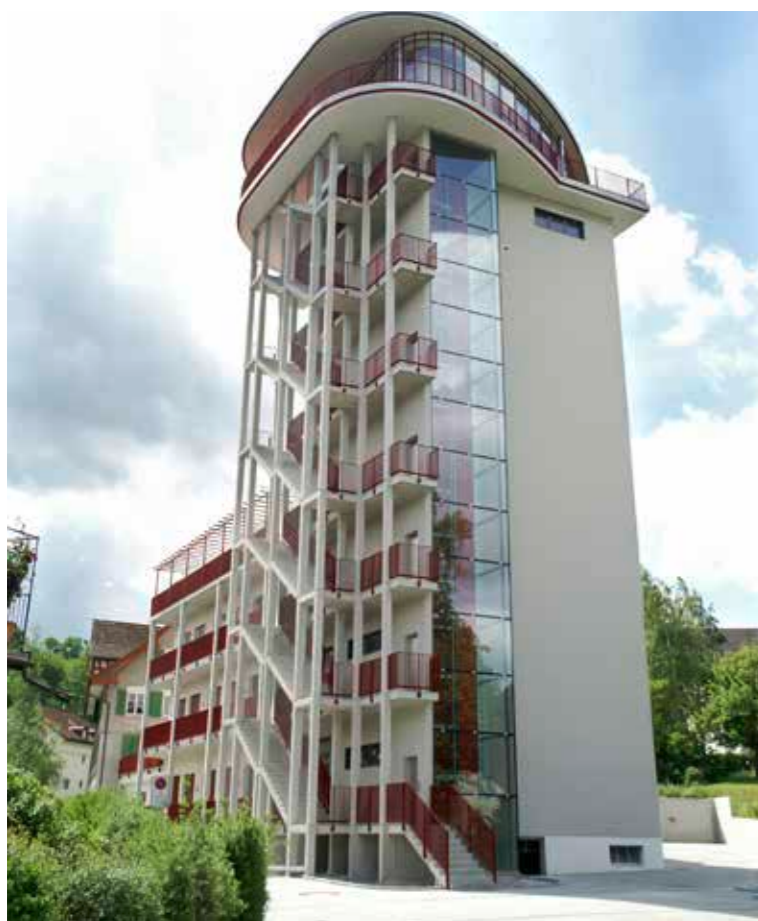
Umnutzung der Mühle Roggwil zum modernen Geschäftshaus
