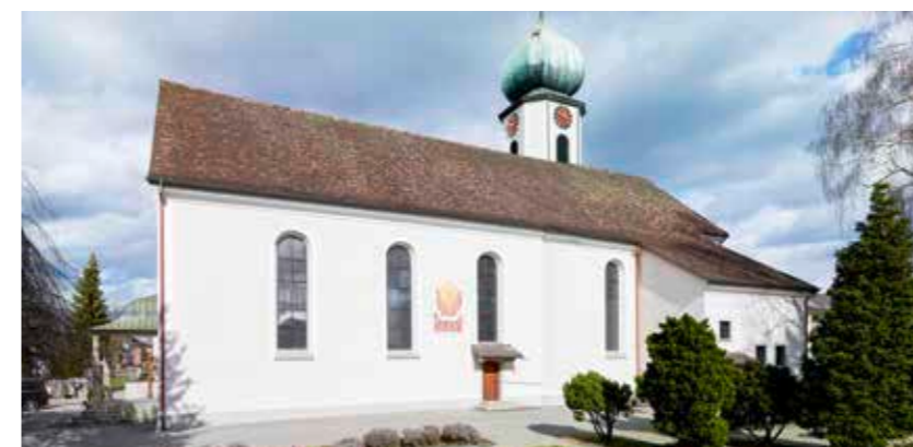
Fassadenrenovation Pfarrkirche St. Jakobus Steinach
