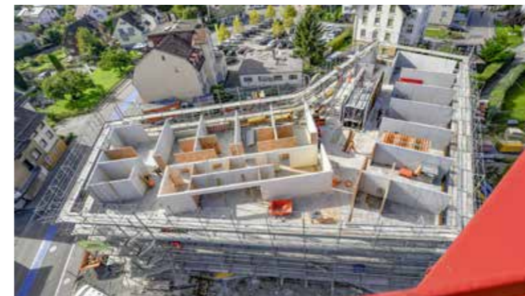
Der «Lebensraum Gartenhof», den er vom Aushub bis zur Einweihung dokumentierte, gehört für Heinze zu den spannendsten Projekten, die er in Steinach begleiten durfte. Für die Bilder aus der Vogelperspektive ist er mehrfach auf den Baukran geklettert – ungesichert wohlgerne. «Von da oben hast du eine Wahnsinns-Aussicht.»
