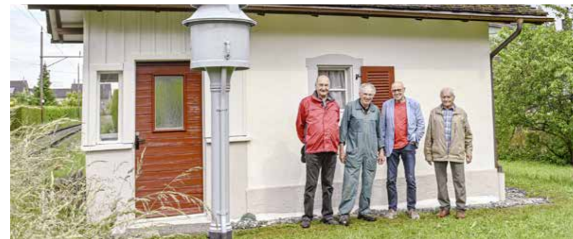
Das alte Bahnwärterhaus ist ein Herzensprojekt von Fritz Heinze. Vor zwölf Jahren organisierte er dessen Sanierung gemeinsam mit dem ehemaligen Gemeindepräsidenten Guido Wüst. «Ich bin genauso leidenschaftlicher «Bähnler» wie ich «Rösseler» bin und der verlotterte Zustand hat mich gestört», ist seine Begründung für das Engagement. Als seine letzte Amtshandlung hat Heinze zusammen mit Paul Weber, Niklaus Dörig und Kurt Treichler (v.l.) das Haus diesen Frühling noch einmal aufpoliert und beginnt dort morgen Samstag um 14 Uhr seine Abschiedsfeier, bevor in den «Gartenhof» disloziert wird. Bilder: Fritz Heinze/z.V.g.
